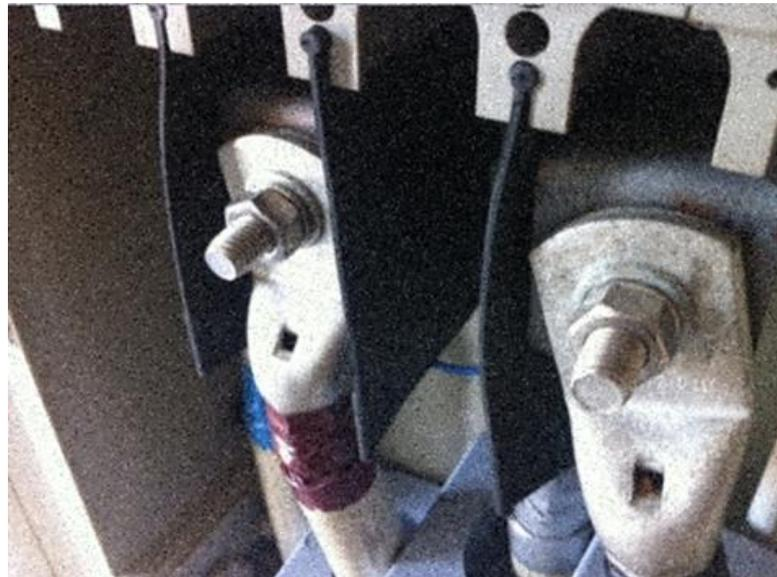
Una parte attiva è accessibile quando può essere raggiunta dal dito di prova, quindi si è in presenza di una parte attiva con grado di protezione < IP XXB, indipendentemente dalla sua posizione nello spazio (a portata di mano, o fuori della portata di mano).
